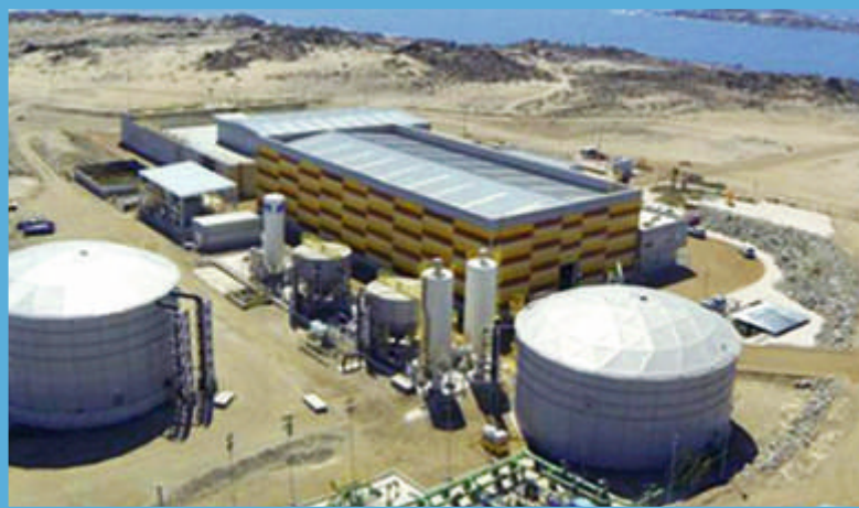
PLANTA DESALINIZADORA DE AGUA
